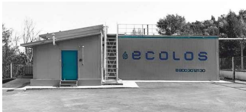
С. БОГАТЫРЬ САМАРСКАЯ ОБЛАСТЬ Станция очистки сточных вод производительностью 200 м 3 /сут
