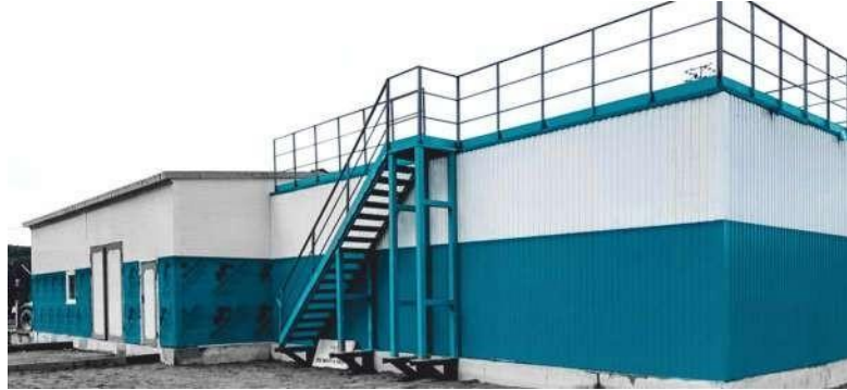
Г. МУРМАНСК, МУРМАНСКАЯ ОБЛАСТЬ ЗАО «РУССКАЯ ТРЕСКА» Станция очистки сточных вод производительностью 181 м 3 /сут
