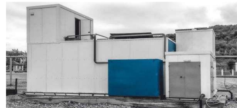
С. ЧИШКИ, ЧЕЧЕНСКАЯ РЕСПУБЛИКА ДЕТСКИЙ ТУБЕРКУЛЕЗНЫЙ САНАТОРИЙ Станция очистки сточных вод производительностью 200 м 3 /сут
