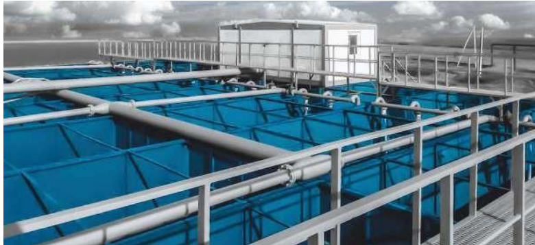
П. МАКАТ, РЕСПУБЛИКА КАЗАХСТАН АТЫРАУСКАЯ ОБЛАСТЬ Оборудования ЛОС-Р-3000 для хозяйственно-бытового
