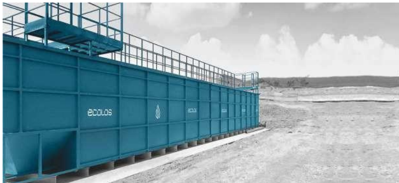
Г. ХЫЗЫ РЕСПУБЛИКА АЗЕРБАЙДЖАН Станция очистки сточных вод производительностью 1 000 м 3 /сут
