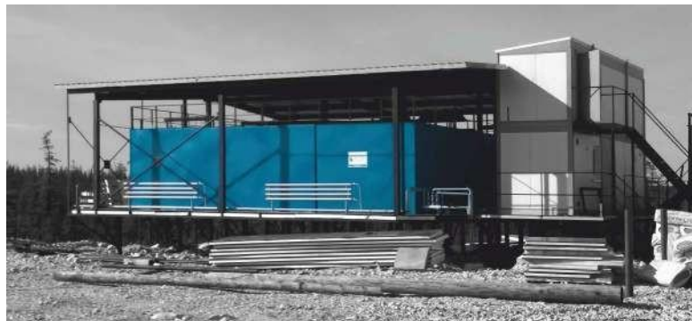
П. БОЛЬШАЯ КУНАВКА ЯКУТСКАЯ ОБЛАСТЬ Станция очистки сточных вод производительностью 150 м 3 /сут
