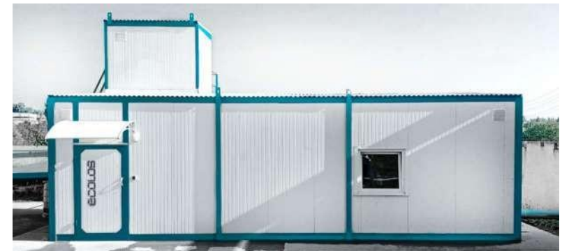
С. МИАССКОЕ, ЧЕЛЯБИНСКАЯ ОБЛАСТЬ ФАБРИКА «УРАЛЬСКИЕ ПЕЛЬМЕНИ» Станция очистки сточных вод производительностью 200 м 3 /сут
