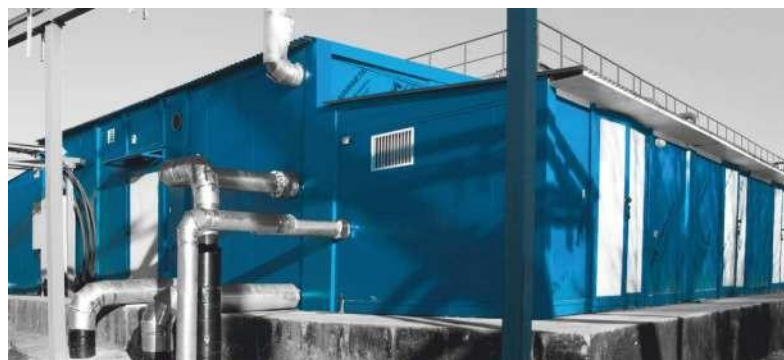
Г. ОКТЯБРЬСК САМАРСКАЯ ОБЛАСТЬ Станция очистки сточных вод производительностью 2 000 м 3 /сут
